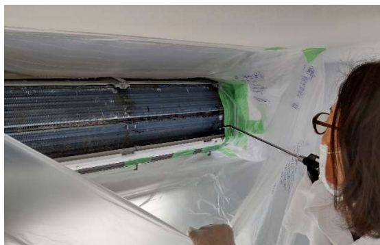
エアコン内部は湿気で黒カビが発生しやすいので、専用洗剤を噴霧し、高圧洗浄機で水洗いします
